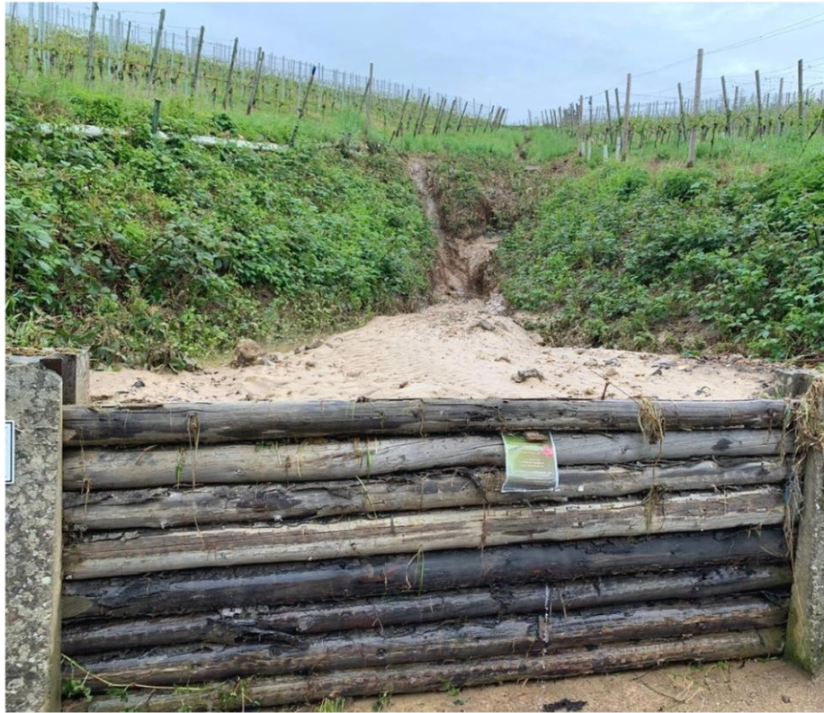
Schlammfang vor einem Außengebietseinlauf im Muckental nach dem Starkregenereignis vom 02.05.2024
