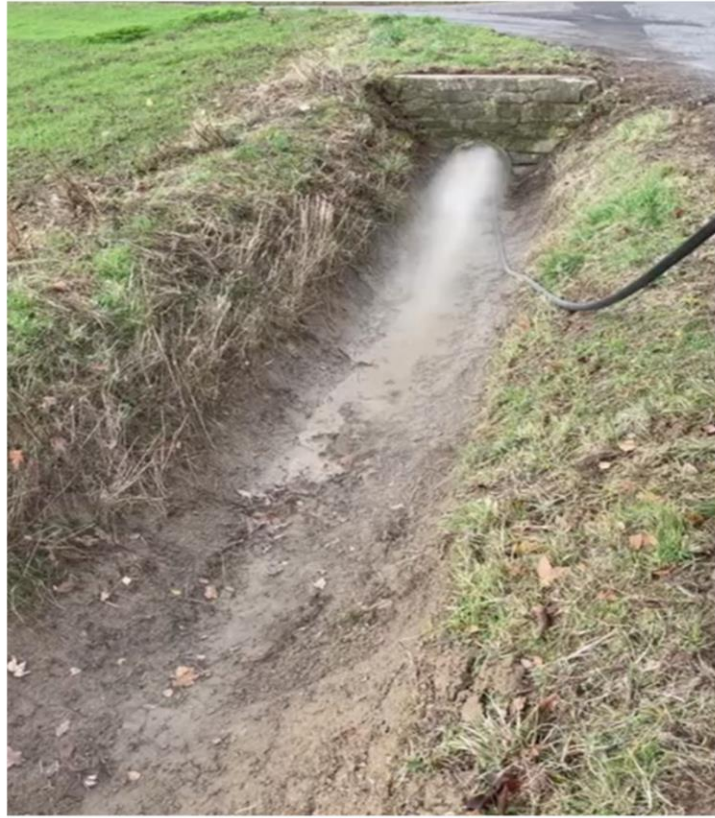
Hochdruck-Rohrreiniger (200 bar) im Einsatz
