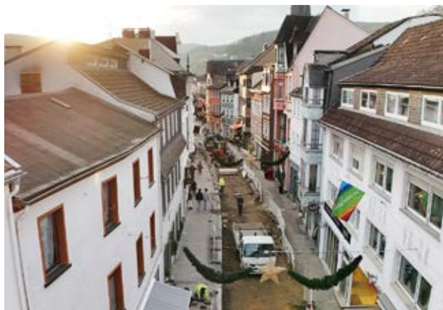
Niederhutstraße Ahrweiler im Wiederaufbau – Barrierefreiheit als wichtiger Bestandteil (Aufnahme Dez. 2025) © Ahr Foto
