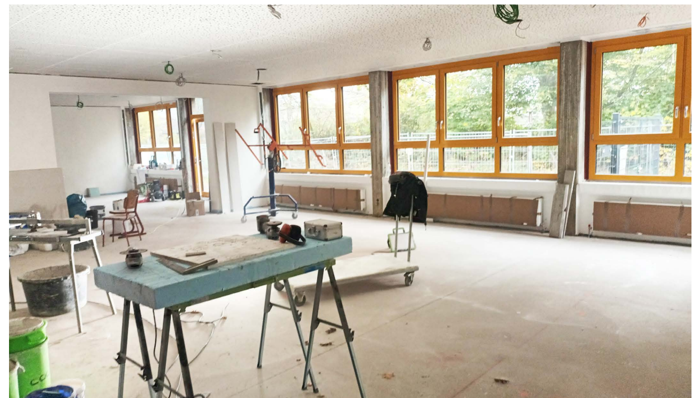
Helle Wände und Decken für die neue Mensa der EKsPlus.
